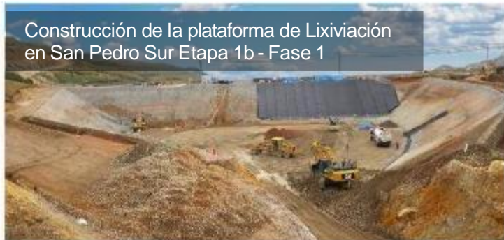
Construcción de Pad de Lixiviación en Pilas San Pedro Sur
